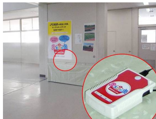
【試験終了後】校舎内ロビーに設置
